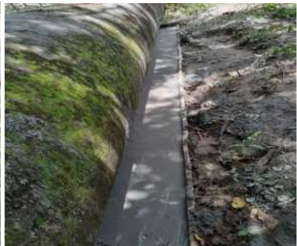
Construcción de placa y pilotes para soporte y protección de tubería.
