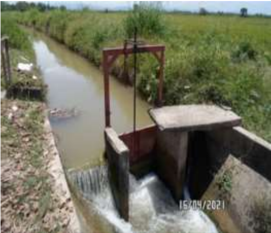
➤ Compuerta de Control - para suministro de riego predio Recuerdo de Manuel Bernate.
