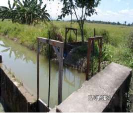
➤ Compuerta de Control - para suministro de riego predio Recuerdo de Manuel Bernate.
