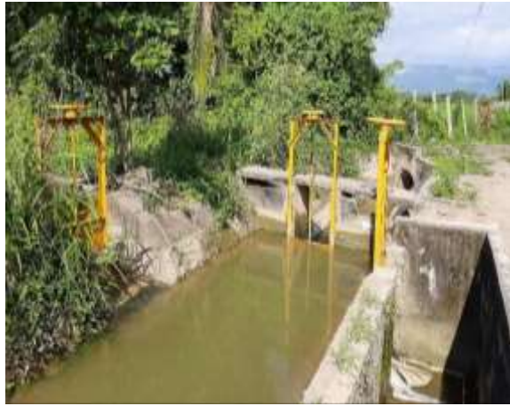
➤ Compuerta de Control - para suministro de riego predio Recuerdo de Manuel Bernate.
