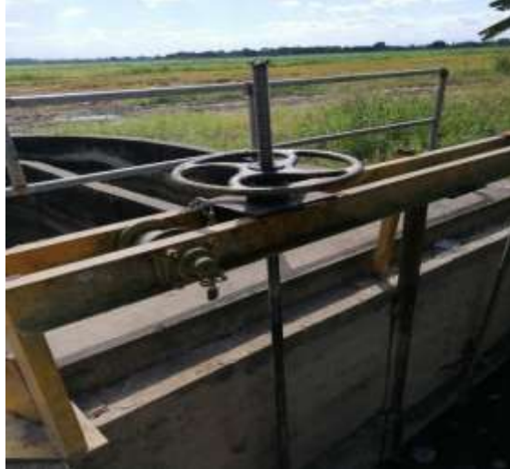
➤ Sitio La Tripletta – Compuerta Para Suministro De Riego Al Canal L-1-3 Sector El Alivio.
