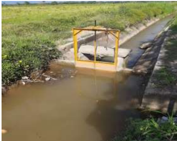
➤ Compuerta de Control - para suministro de riego predio Recuerdo de Manuel Bernate.
